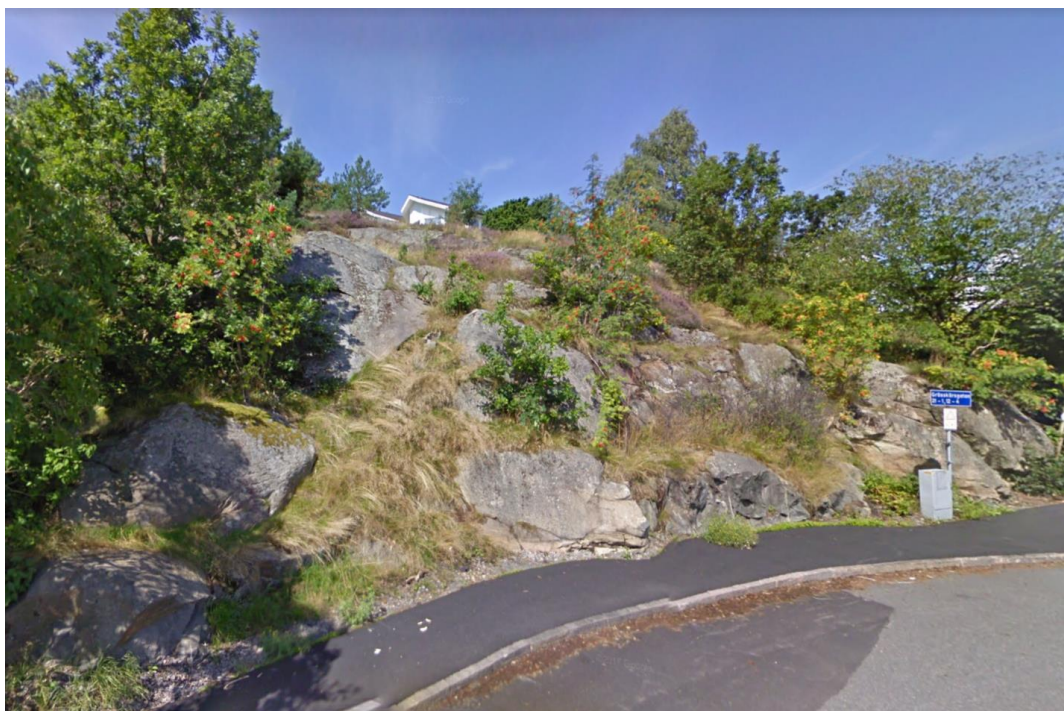
Foto 2. Stabil bergslänt strax utanför planområdet i söder (Foto från Google map)
